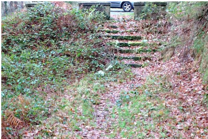
Foto 11. Estado de abandono no que se atopa o acceso á Fonte das Boliqueiras
